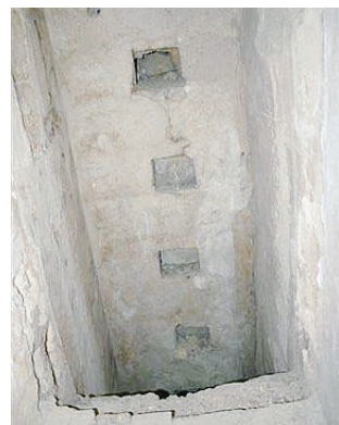
Il cunicolo che porta alla cisterna
