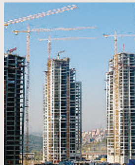
Palazzi in costruzione
